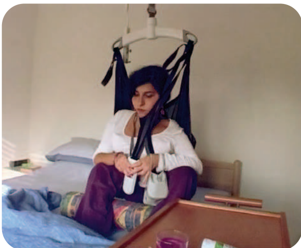
Fig. 4: Il binario sollevatore, fissato al soffitto, permette a Lucia di spostarsi autonomamente dalla sedia al letto
