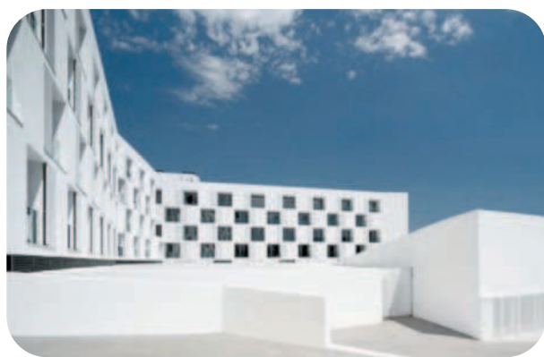
Fig. 3. Barcellona. Facciata sud e centro civico delle residenze di Carrer Can Travi nella periferia Nord. Progetto di Sergi Serrat.
